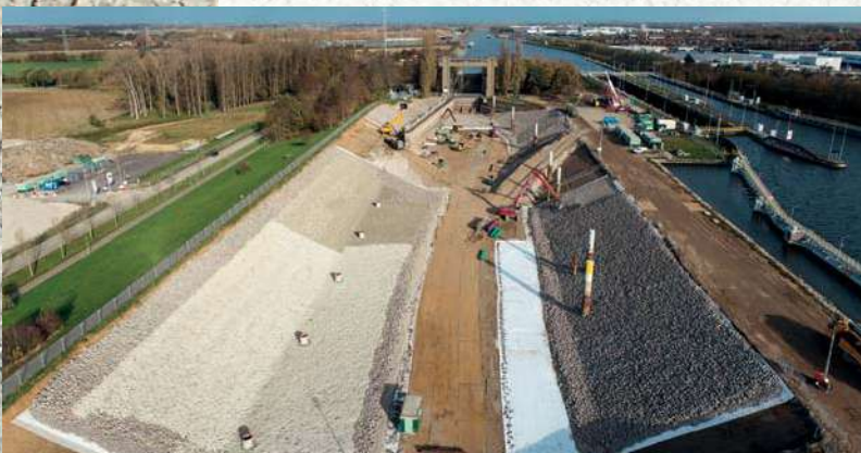
Afdichting voorhaven sluiscomplex Born met de installatie van bentonietmatten op de kanaalbodem en de taluds. Boven op de afdichting worden zware waterbouwstenen aangebracht gepentreed met beton.
