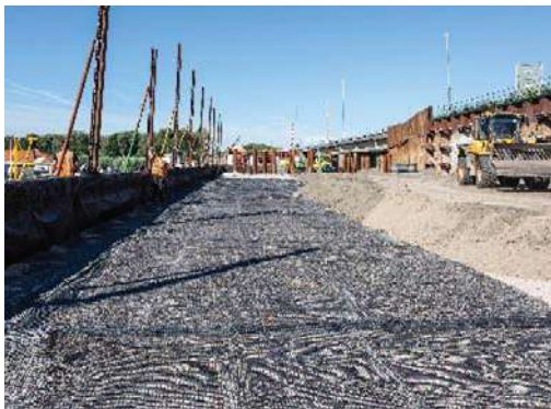
Figuur 12 – Constructie KW45-61 in aanbouw.
