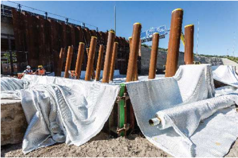
Figuur 8 – Matras in aanbouw rondom de palen van Schinkelbrug 1.
