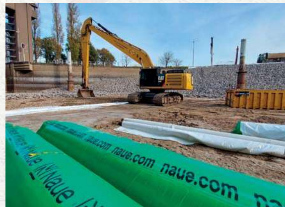
Afdichting voorhaven sluiscomplex Born met de installatie van bentonietmatten op de kanaalbodem en de taluds. Boven op de afdichting worden zware waterbouwstenen aangebracht gepentreed met beton.
