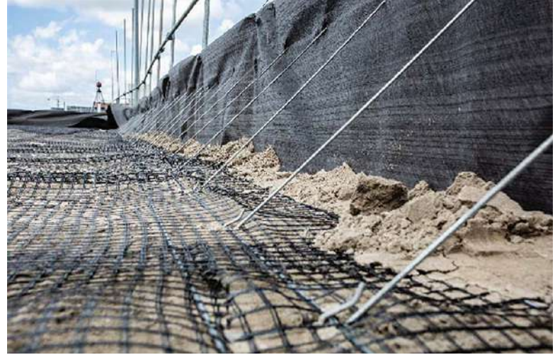
Figuur 4 – Detail van een gewapende grondlaag in combinatie met het VB-systeem.
