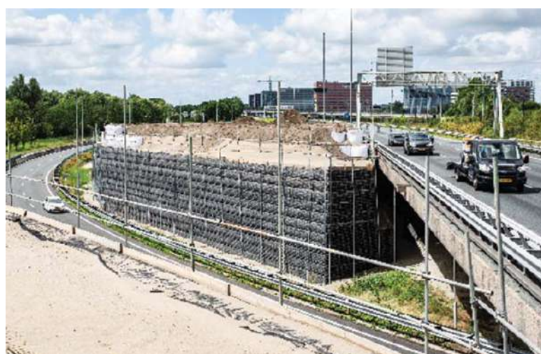
Figuur 7 – Tijdelijke gewapende grondconstructie TK-03.
