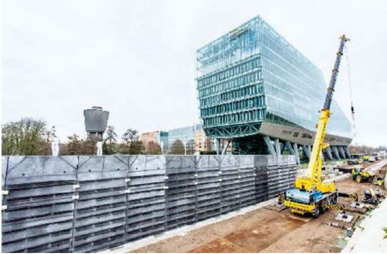
Figuur 3 – Actieve wanden vanaf de binnenzijde met de ingestorte startergrids.
