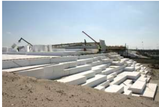
Lichtgewicht ophoging viaduct spoorlijn Alphen a/d Rijn - Gouda
