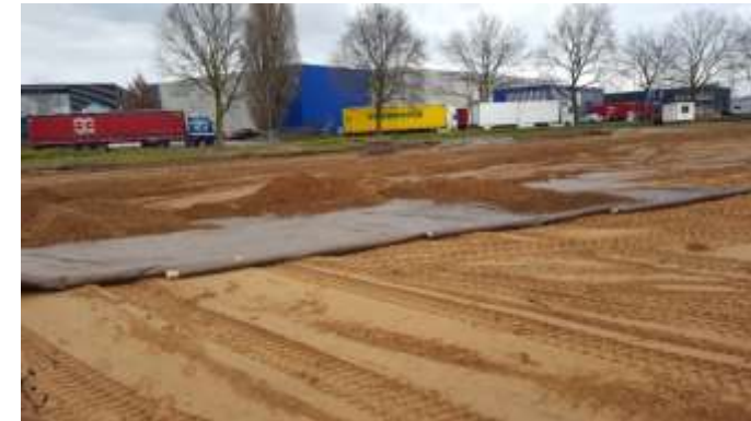
Bouwterrein met biobased scheidingslaag
