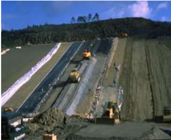
Afdichting en verankering leeflaag vuilstortplaats
