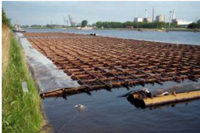
Zinkstuk matras met filterlaag in bodembescherming, Rotterdam
