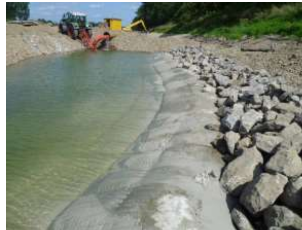
Betonmatras als beschoeiing, Berg a/d Maas
