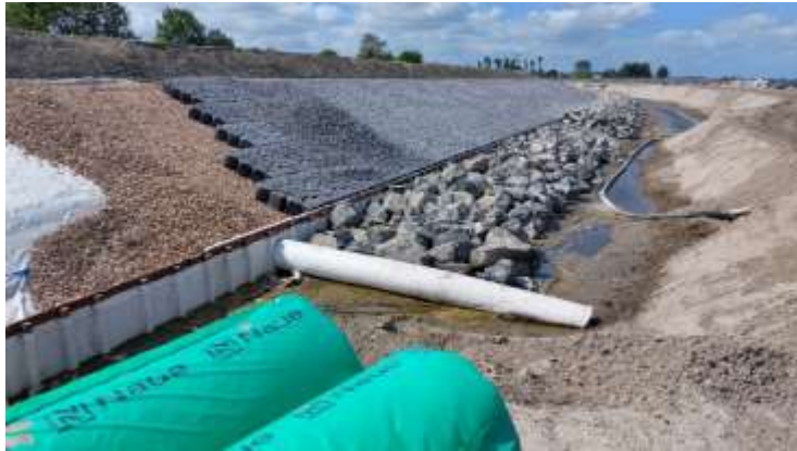
Filterlaag onder steenbekleding Markermeerdijken
