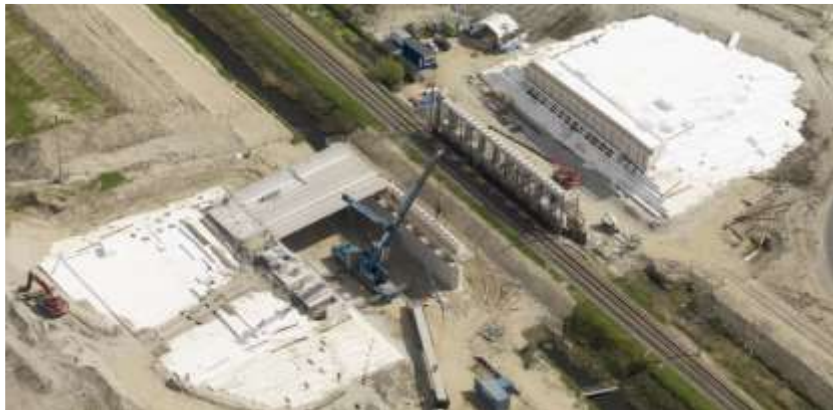
Lichtgewicht ophoging viaduct spoorlijn Alphen a/d Rijn - Gouda
