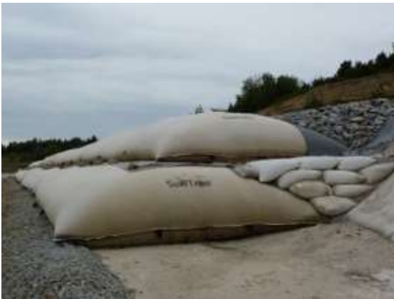
Bentonietmat ter vervanging van klei-afdichting dijkversterking, Beesel
