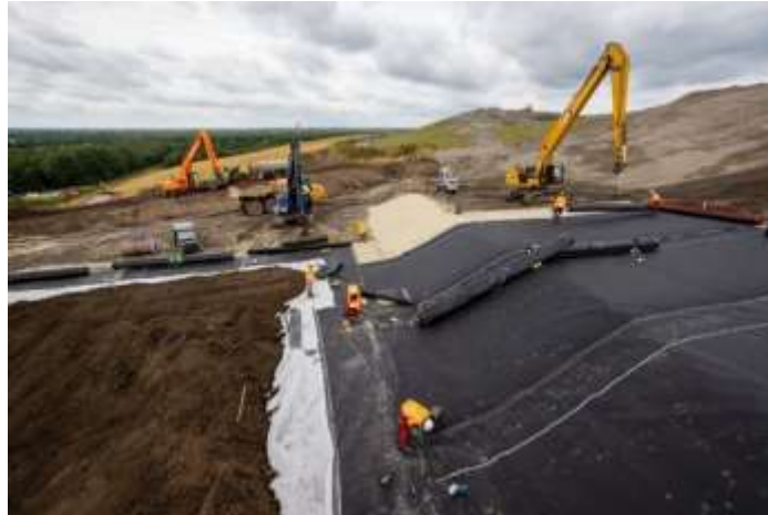
Afdekking stortplaats, Twente
