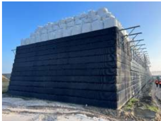
Gewapende grond, Moerdijk
