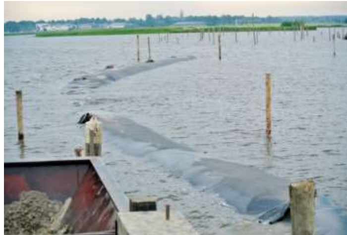
Geotextiel gevulde elementen
