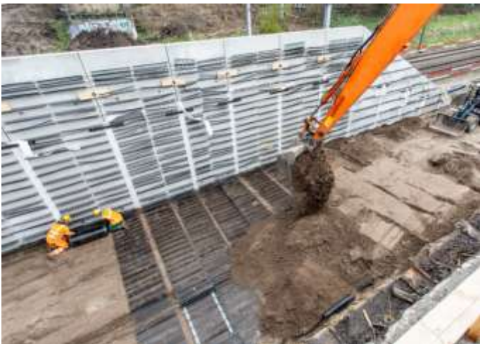
Gewapende grondconstructie, Steenwijkerland
