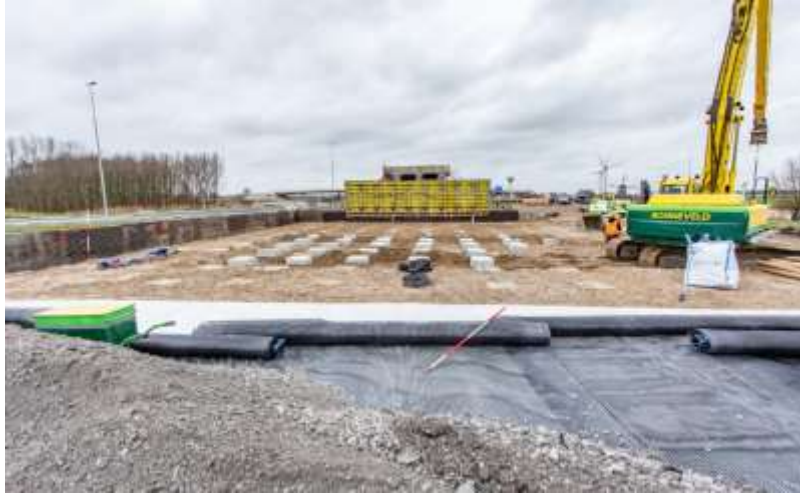
Paalmatras constructie, A4 Hofvliet, Leiden
