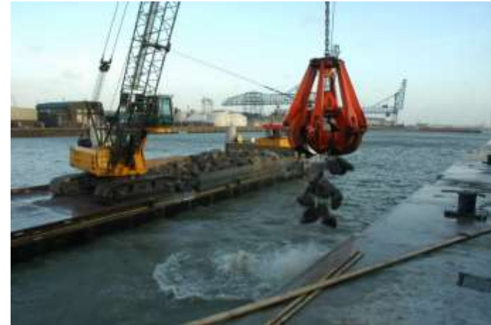
Zinkstuk matras met filterlaag in bodembescherming, Rotterdam
