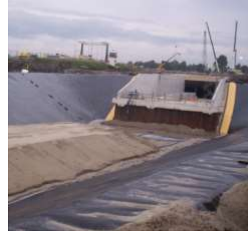
Folieconstructie toerit aquaduct Langdeel
