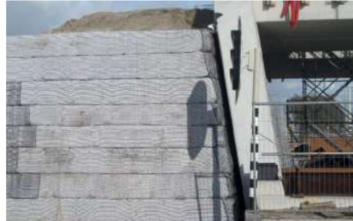
Grondruk ontlastingsconstructie achter betonnen muur, zonder verbinding
