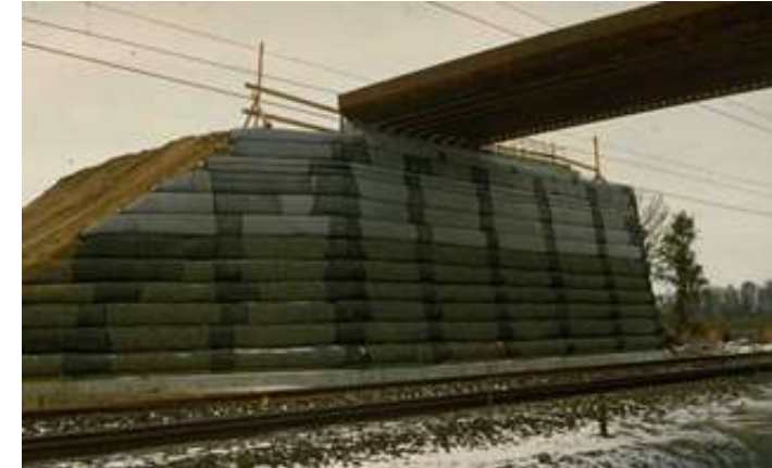
Grondruk ontlastingsconstructie achter betonnen muur, zonder verbinding
