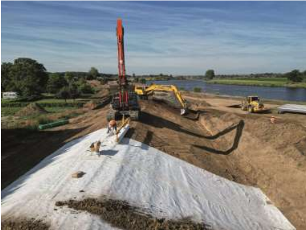
Bentonietmat ter vervanging van klei-afdichting dijkversterking, Beesel
