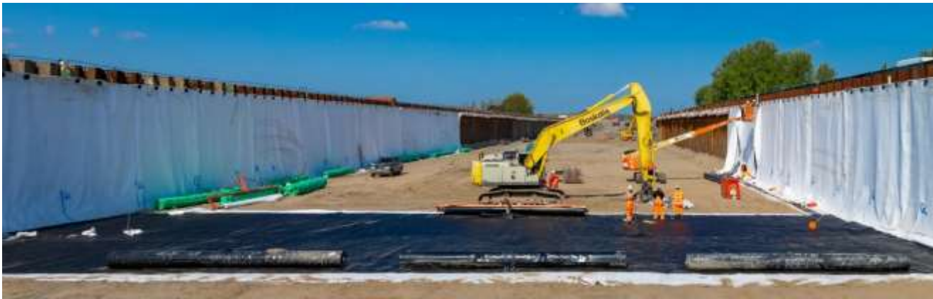
U-polder met folieconstructie en nonwoven bescherm laag, N206 Katwijk
