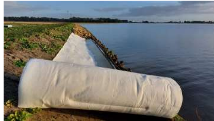
Filterlaag biobased nonwoven onder steenbekleding Hondhalstermeer
