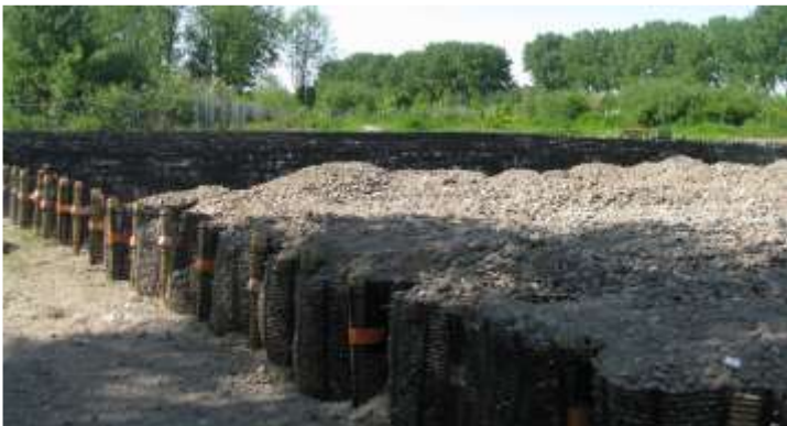
Kraanopstelplaats windturbine, Vlaardingen
