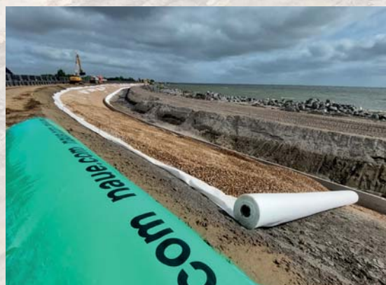
Dijkversterking Markermeerdijken met installatie van een hoogwaardig filtersysteem met Naue Secutex op de taluds van de waterkering. Hier bovenop wordt een steenbekleding aangebracht met stortsteen en zetsteen.
