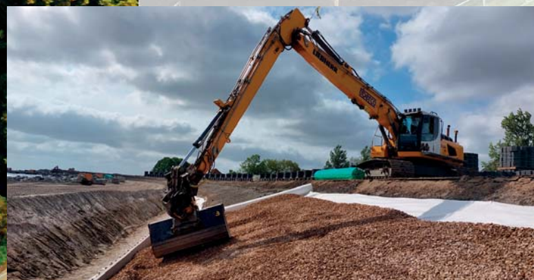
Dijkversterking Markermeerdijken met installatie van een hoogwaardig filtersysteem met Naue Secutex op de taluds van de waterkering. Hier bovenop wordt een steenbekleding aangebracht met stortsteen en zetsteen.
