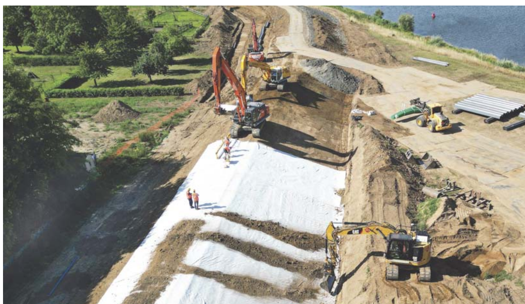
Figuur 1 – Uitvoering bentonietmatten dijkversterking Beesel op het buitentalud en kruin van de dijk en afwerking met een leeflaag van grond.
