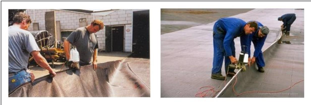
Figuur 3.12 Naaien in de overlap met een handnaaimachine
