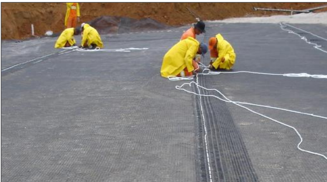
Figuur 3.13 Naaien in de overlap met een handnaaimachine. Naaien van geogrids in Brazilië. Te zien is dat het geogrid zo is geweven dat ze eenvoudig aan elkaar kunnen worden genaaid. (foto's van Werner Biffinger, Vectror, Brazilië).
