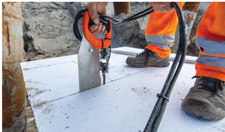
Figuur 6 – Detail inpassing EPS-blokken rondom de paalfundering.
