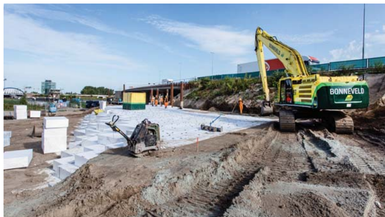
Figuur 4 – Overzicht opbouw EPS-constructie achter landhoofd zuid-oostzijde.
