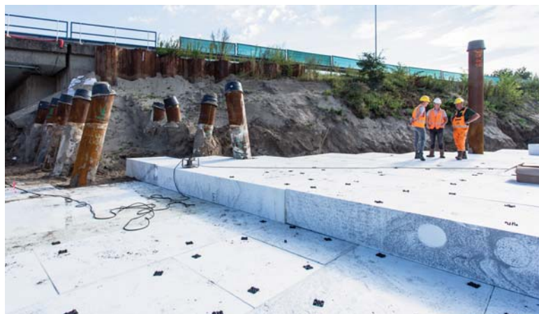
Figuur 5 – Overzicht opbouw EPS-constructie onder en naast landhoofd zuidoostzijde.
