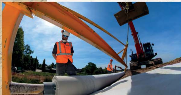
Dijkversterking Beesel met installatie van bentonietmatten op de kruin en taluds van de waterkering voor volledige vervanging van een water afdichtende kleilaag van 1 meter (Waterschap Limburg, Mourik Infra, FL).
