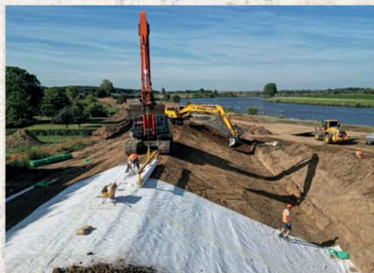
Dijkversterking Beesel met installatie van bentonietmatten op de kruin en taluds van de waterkering voor volledige vervanging van een water afdichtende kleilaag van 1 meter (Waterschap Limburg, Mourik Infra, FL).
