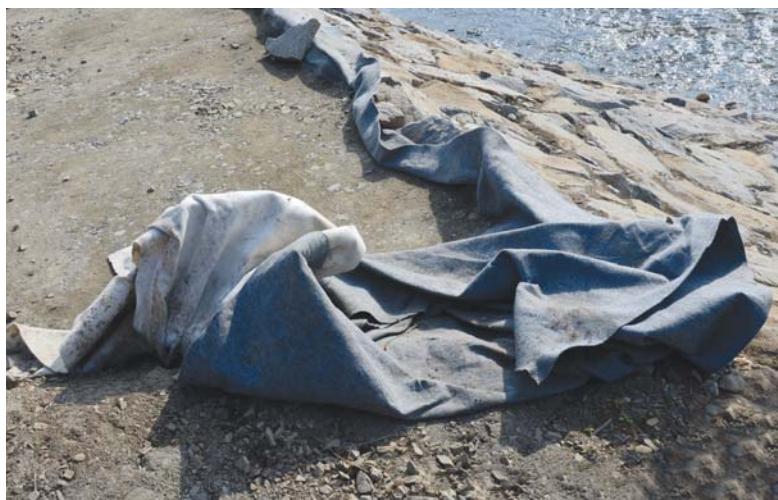
Figuur 1 – Voorbeeld van een losliggend stuk geotextiel bij een oeverconstructie – op te ruimen en af te voeren naar een erkende verwerker ter voorkoming van verspreiding naar de omgeving. (Shutterstock)
