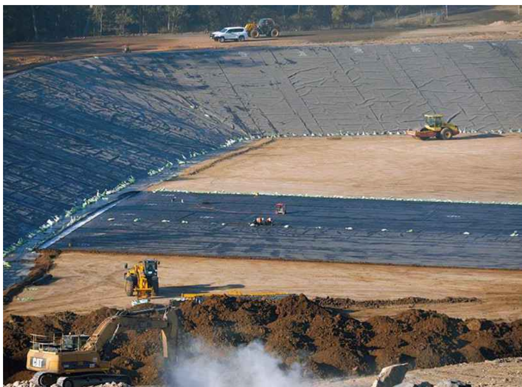
Figuur 4 – Aanbrengen HDPE folie in den droge, EPC project in Australië (Bron: Paulson en Morris, 2022).
