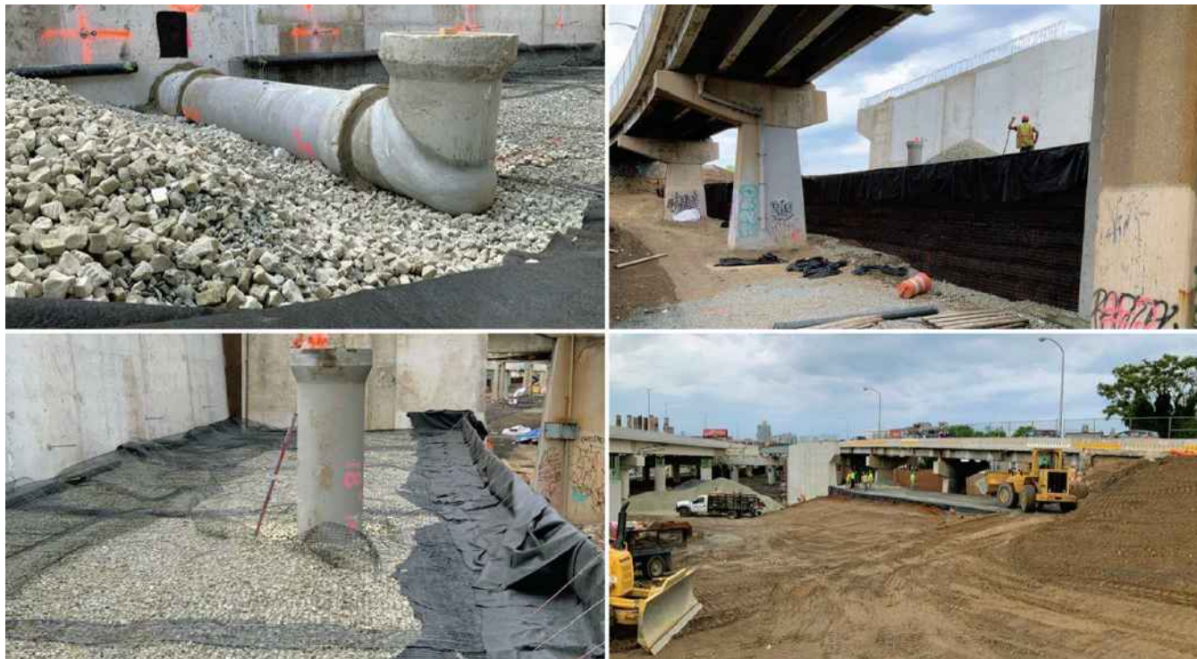
Figuur 3 – Bouwproces gewapende grond met aanvulmateriaal van glasaggregaat (Loux et al., 2022).
