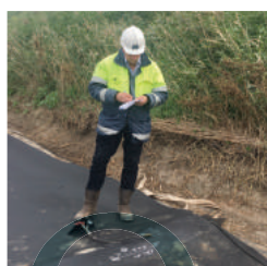
Inspectie in het werk
