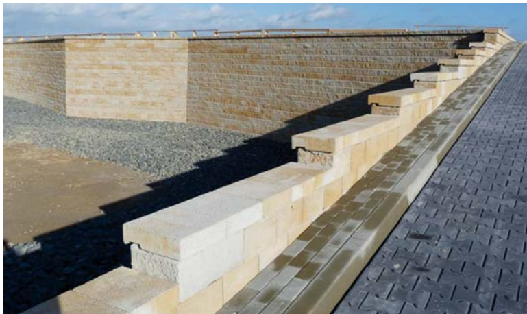
Figuur 3 – Blokkenwand Kademuurconstructie bij oplevering.
