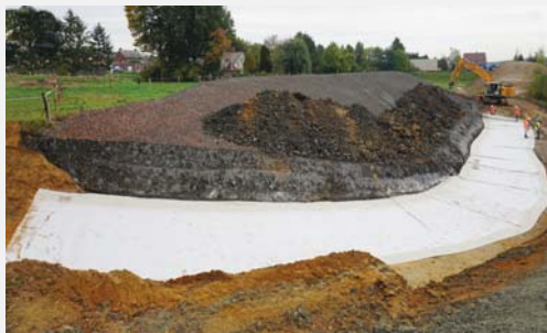
Figuur 2 - Dijkversterking Neer voorland-versterking met aanleg Bentofix bentonietmat als maatregel voor piping (Waterschap Limburg).
