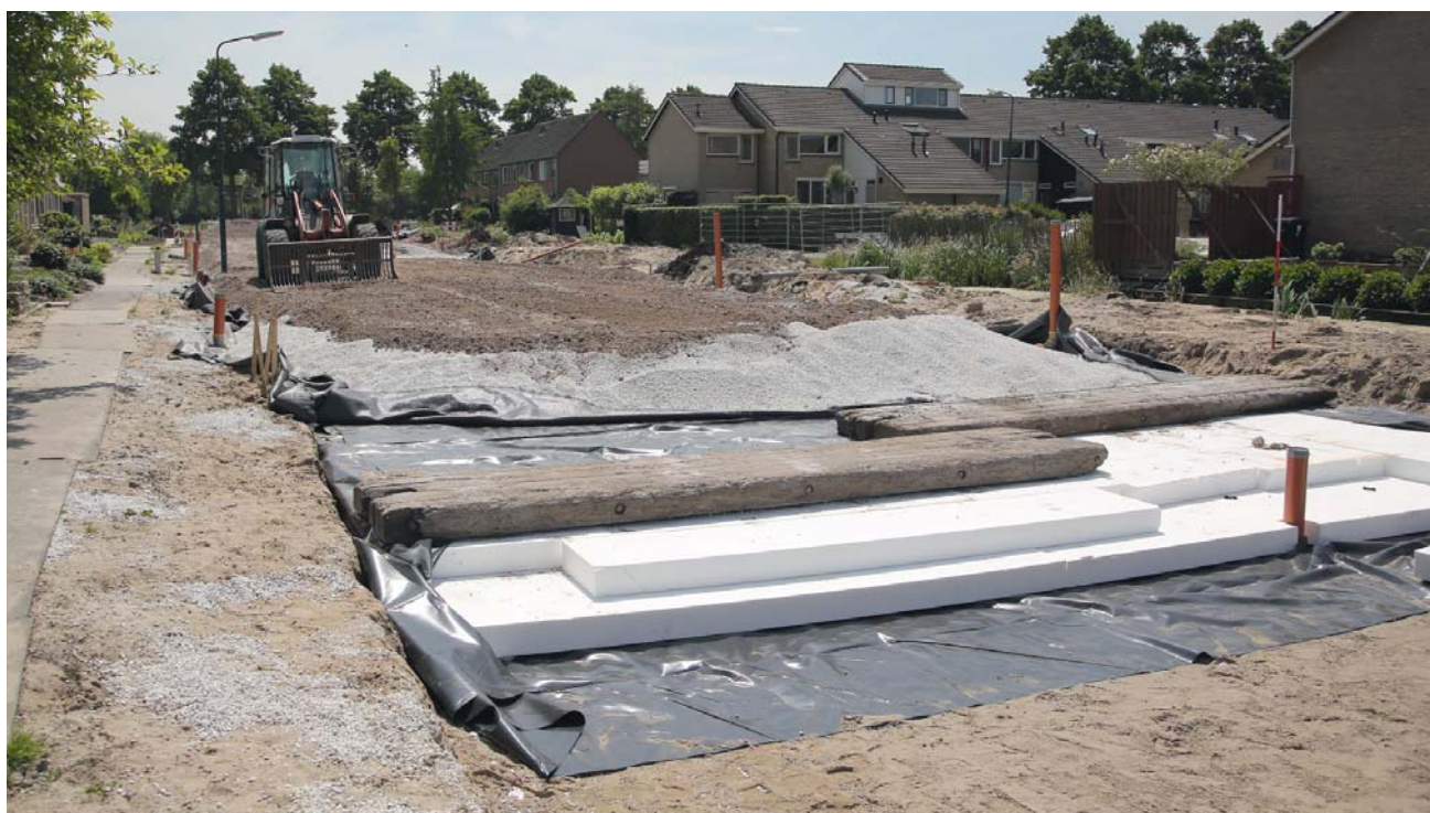
Figuur 1 – Zorgvuldige uitvoering bij het aanbrengen van EPS (let op de draglineschotten tegen het wegwaaien) (bron Kwast e.a., GeoKunst, december 2018).
