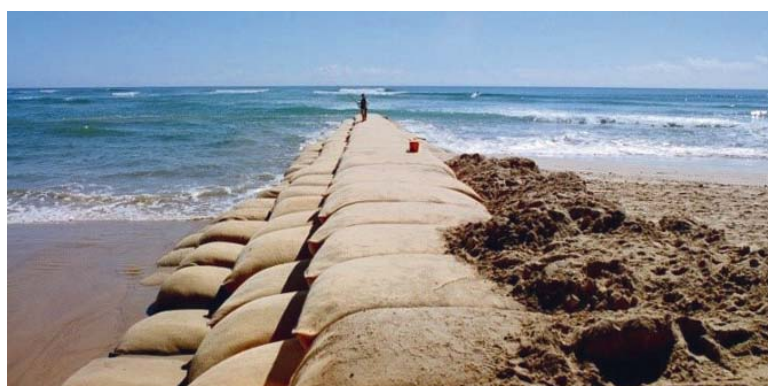
Foto 3e – Geotextiele tubes als talusbekleding [PIANC 2011].
