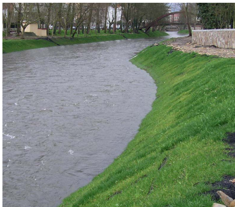
Foto 4b – Zware 3D erosiemat (Enkamat A20) gevuld met steenslag/bitumen en begroeiing door de mat (Low & Bonar).
