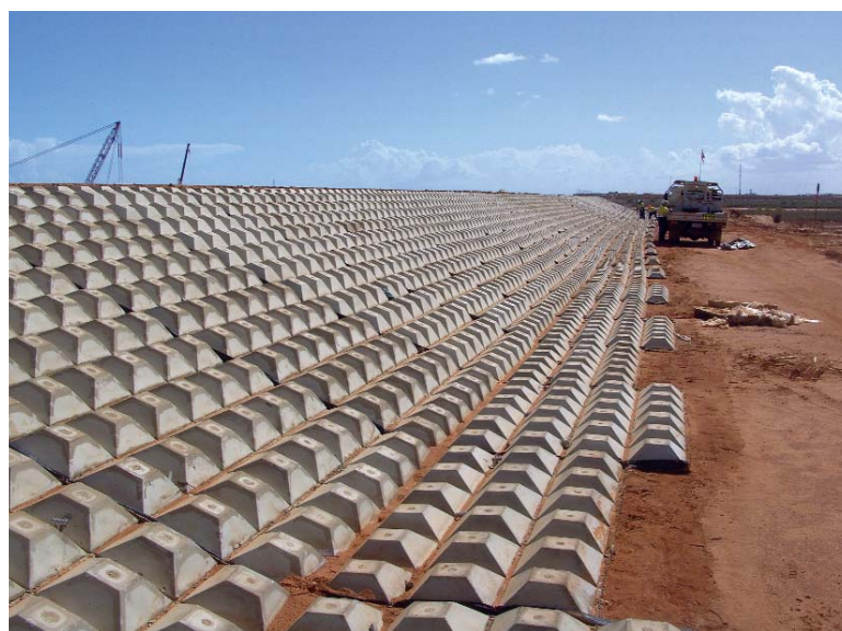
Foto 4d – Betonblokkenmatten op een geotextiel 3D-lussendoek EnkaLoopPile (Low & Bonar).
