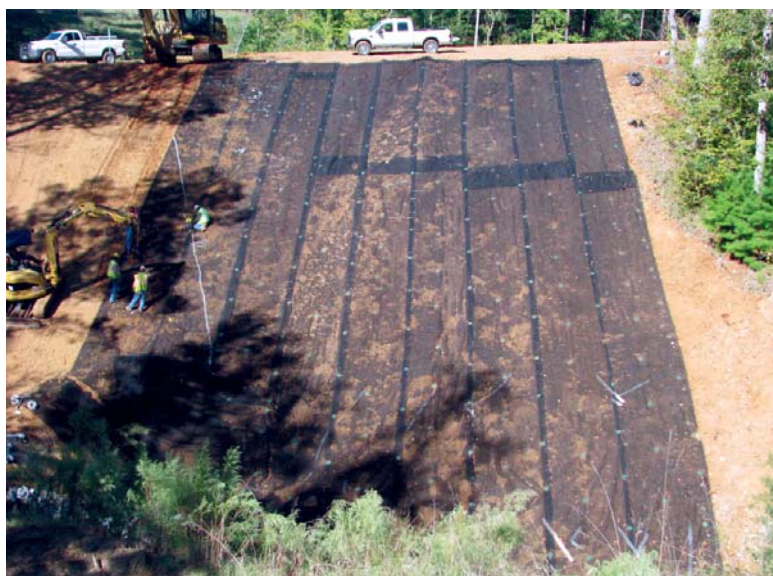
Foto 4c – Gewapende 3D-erosiemat (Enkamat R45) op een steil talud met verankering (Low & Bonar).
