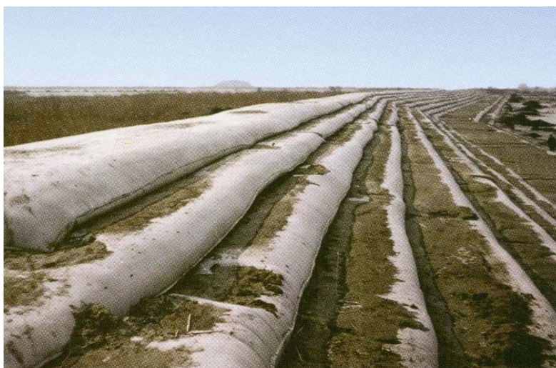
Figuur 3d – Krib, kern gemaakt van geokunststof zakken. Maroochy, Queensland, Australia [Restall et al., 2002].
