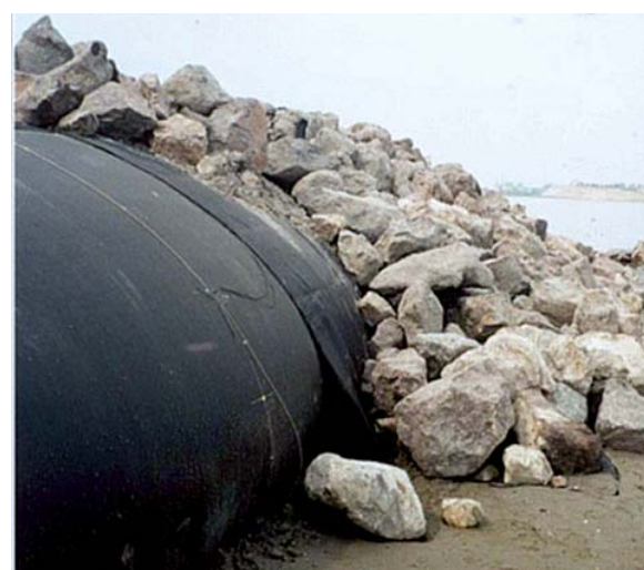
Foto 3f – Afdekking van een Geotube TenCate USA.
