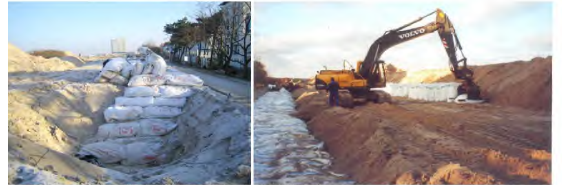
3.1.4.2 Bau des Geotextilwalles in Wamemünde Ost im Jahr 2005/06 (JÄGER).
