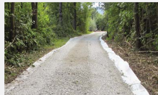
Figuur 3 - Aanleg tijdelijke toegangsweg met Secutex Green, een 100% biodegradeerbaar non-woven vlies, als scheidings-doek voor verhardingsmateriaal en ondergrond.
