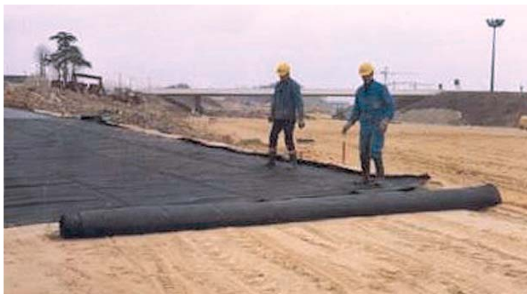
Figuur 1 – Aanleg van autoweg A15 bij Parijs, sectieweg St. Gratien 95100 Argenteuil (1974). Materiaal Nicolon Geolon 200.
