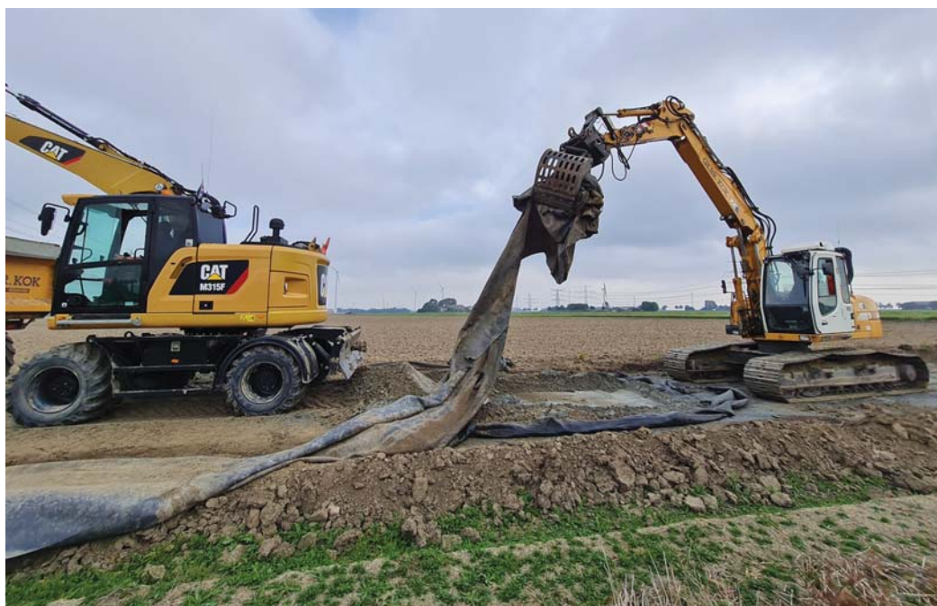
Figuur 8 – Het gecontroleerd verwijderen van een HM PP-weefsel, toegepast in een zwaarbelaste bouwweg.
