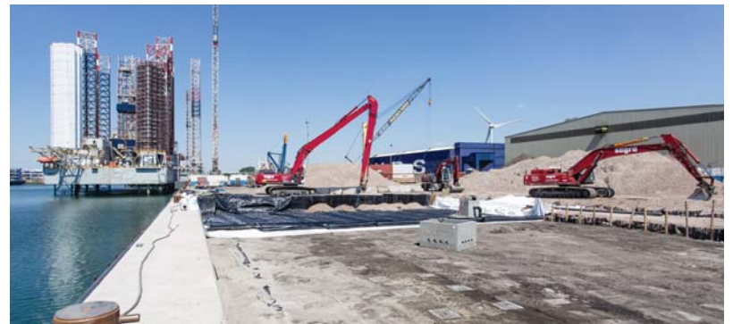
Figuur 6 – Uitvoering paalmatrasconstructie en overgangsconstructie met geogrid cellenstructuur kade Sagro Vlissingen.
