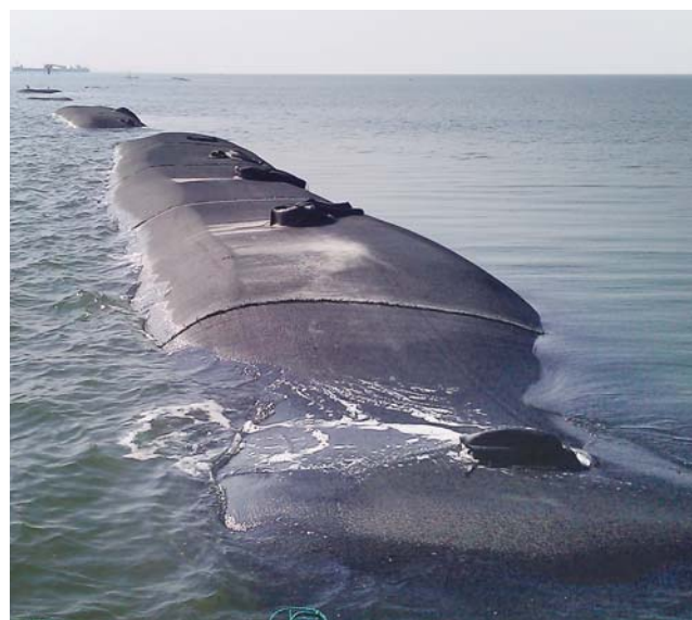
Figuur 8 – Toepassing geotextiele tube en container in slibopvang Markermeer.
