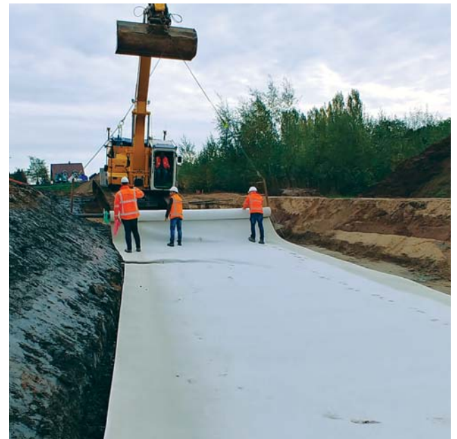
Figuur 10 – Aanleg bentonietmat als voorlandverbetering bij dijkversterking Neer, Waterschap Limburg, oktober 2019.
