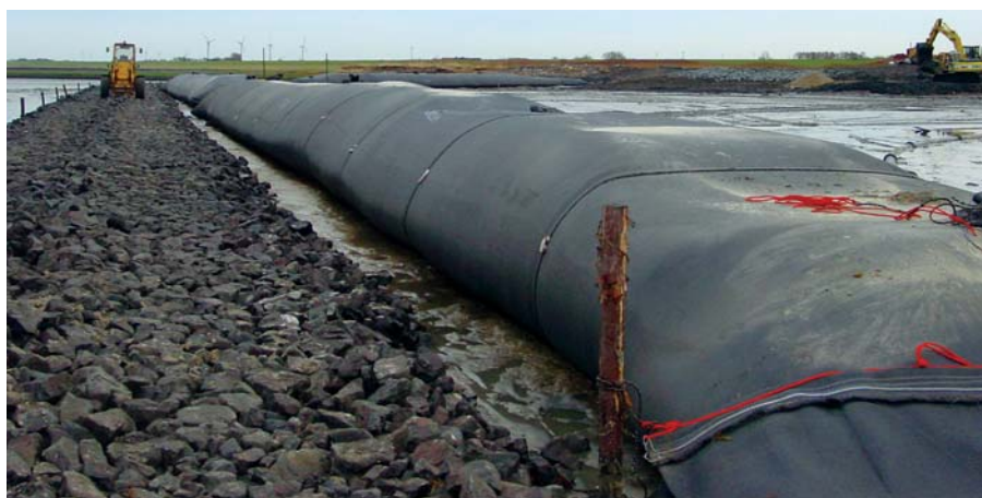
Figuur 7 – Toepassing geotextiele tube in de kern van een dam.
