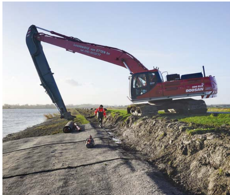
Figuur 11 – Aanleg erosiebescherming in de natte met een zware voorgevulde structuurmat op oevers roeivijver Zevenhuizen.
