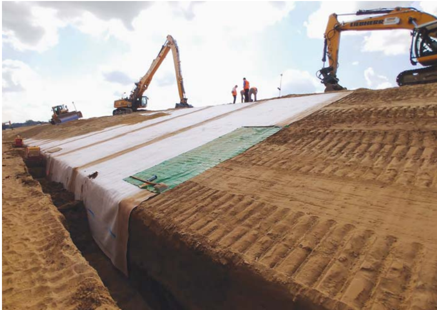
Figuur 9 – Aanleg bentonietmat als afdichting op de Oderdijk Duitsland in plaats van een conventionele kleilaag.
