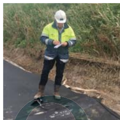
Inspectie in het werk
