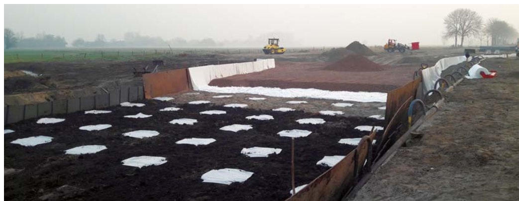
Figuur 1 – Meetvak van de paalmatras van rotonde de Wetering in aanbouw. De paaldeksels worden bedekt met non-woven geotextiel. Dit beschermt de geotextiel-wapening die daarbovenop komt. Op de meetlocatie is de zandige ondergrond vervangen door slap veen.
