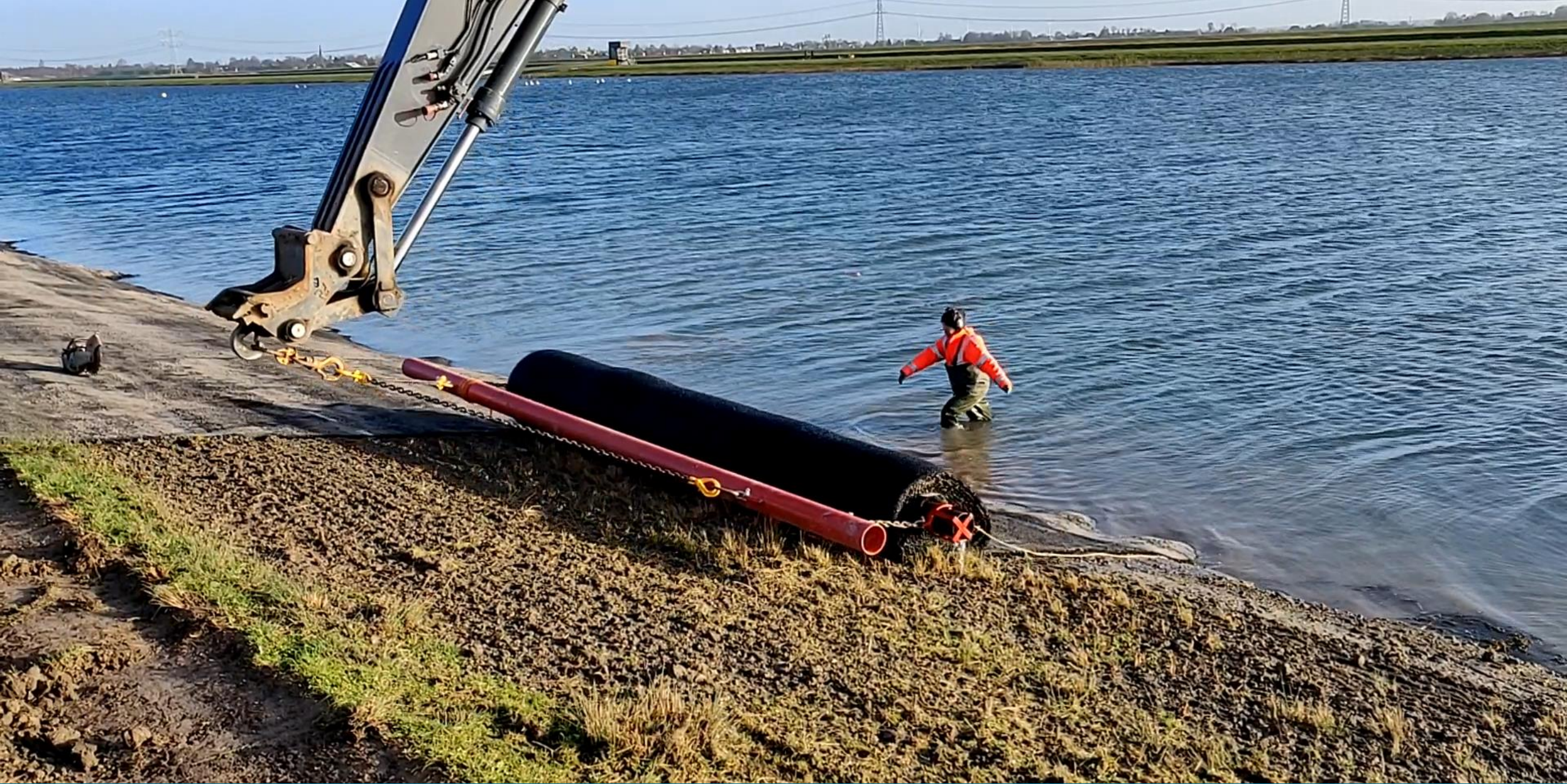
Erosiebescherming oevers roeivijver Zevenhuizen (video) Driedimensionale voorgevulde structuurmat voor erosiebescherming - installatie in den natte met een standaard evenaar
