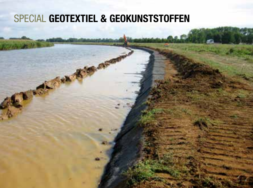
Installatie van EnkaMat A20 voor erosiepreventie, Oude IJssel, Doetinchem.
