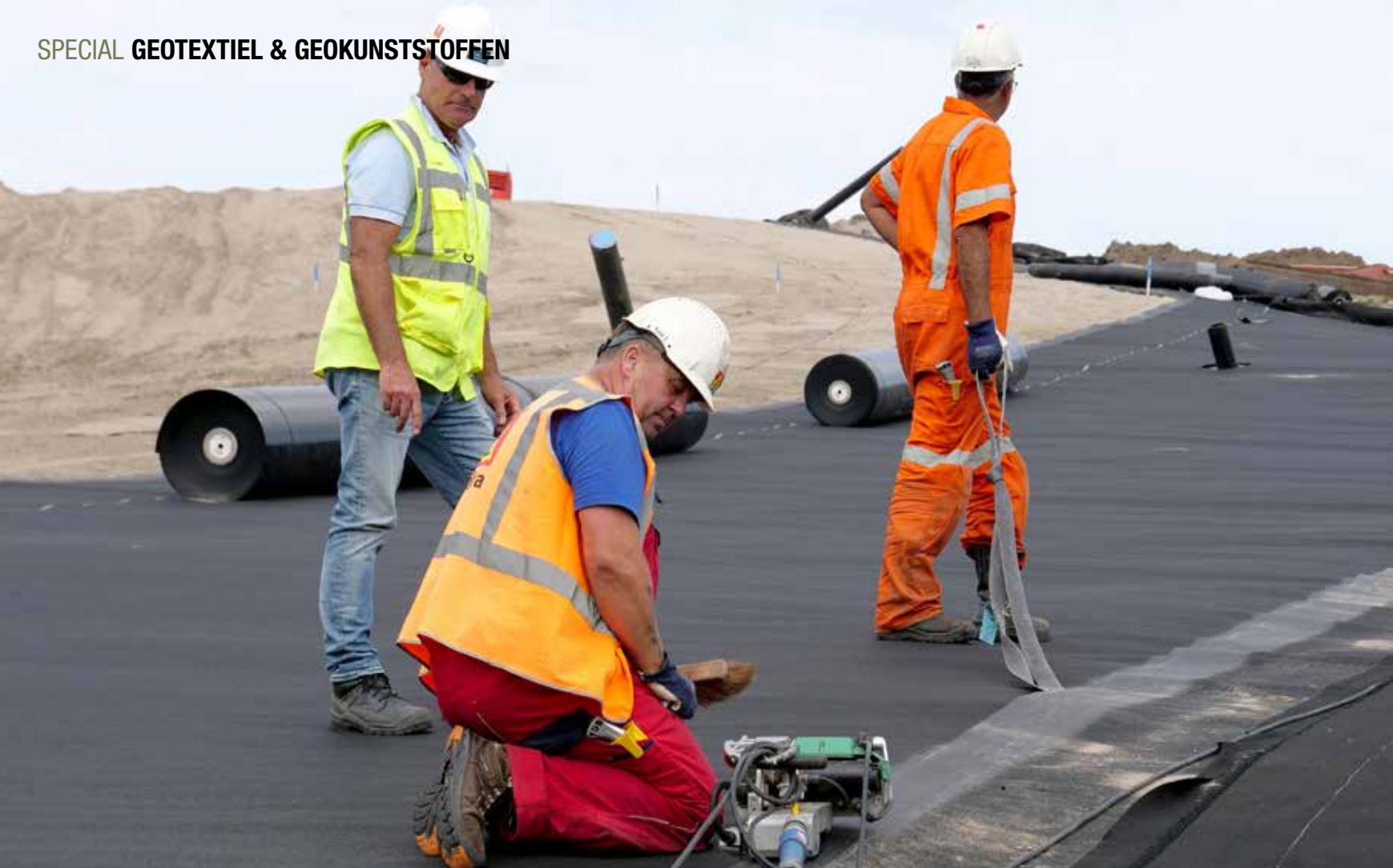
Inspectie bij aanleg kunststoffolie.
