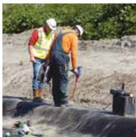
INSPECTIE IN HET WERK
