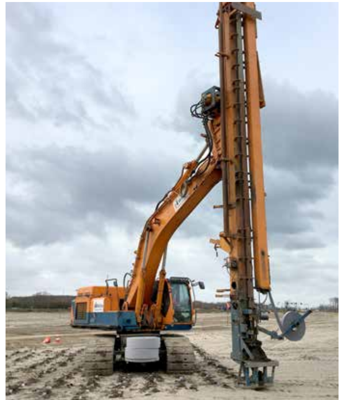
Colbondrain voor versnelde grondconsolidatie, project de Groene Boog in Rotterdam.
