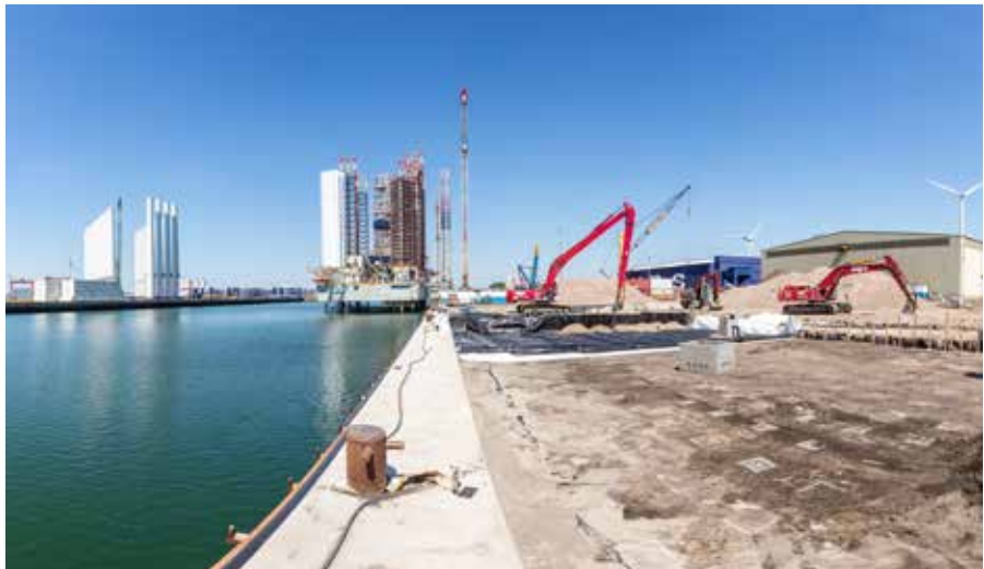
Met een draagkracht van minimaal 150 kN/m 2 is Sagro klaar voor de sloop van de zwaarste onderdelen van de grootste boorplatformen.
