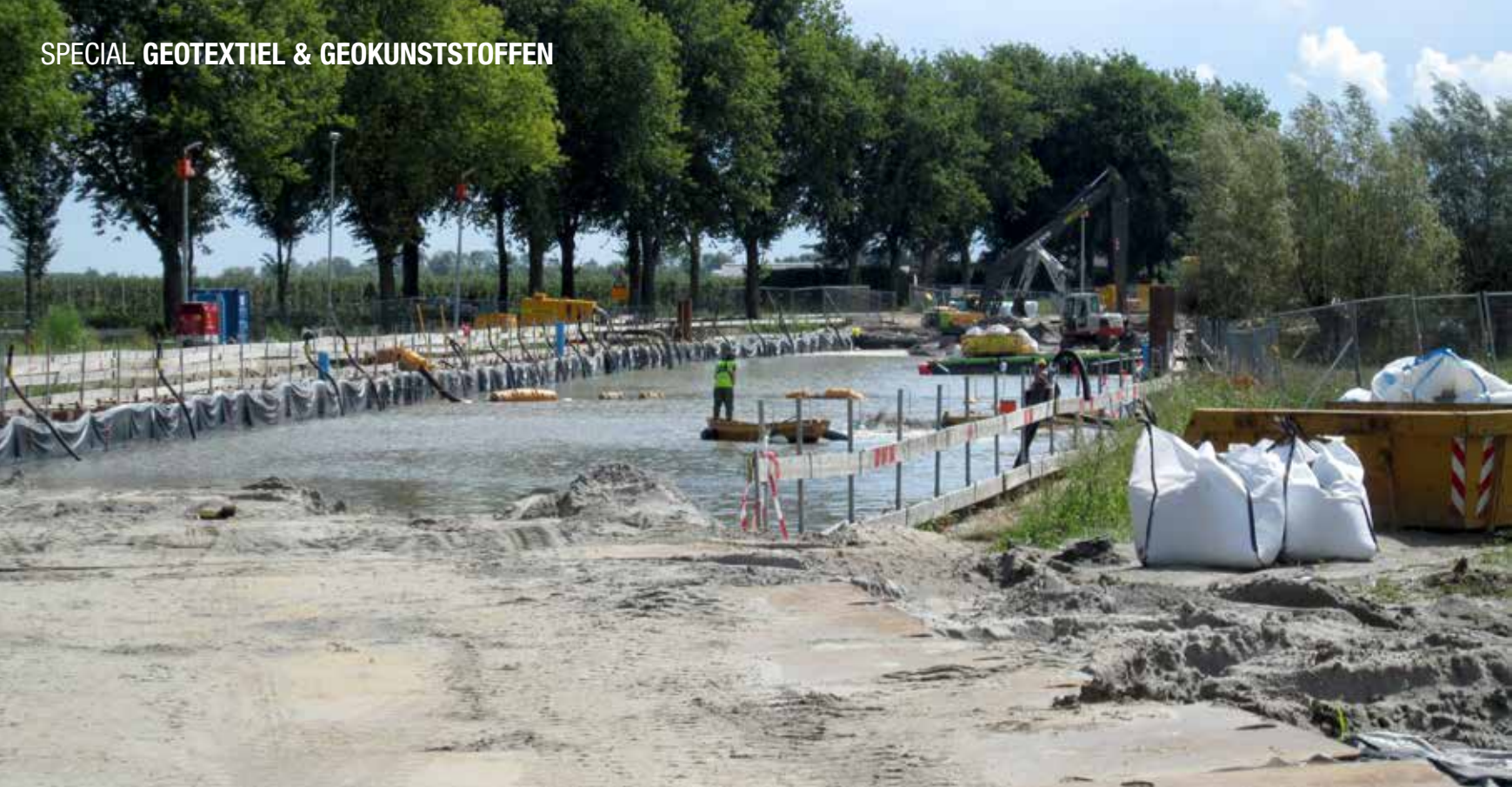
Aanleg folieconstructie in den natte N421 te Houten.
