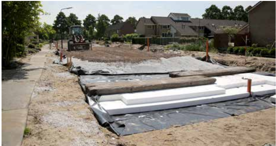
Reconstructie voorhuis te Kamerik met aanleg EPS-platen met folie, Bimsaanvulling en menggranulaat.
