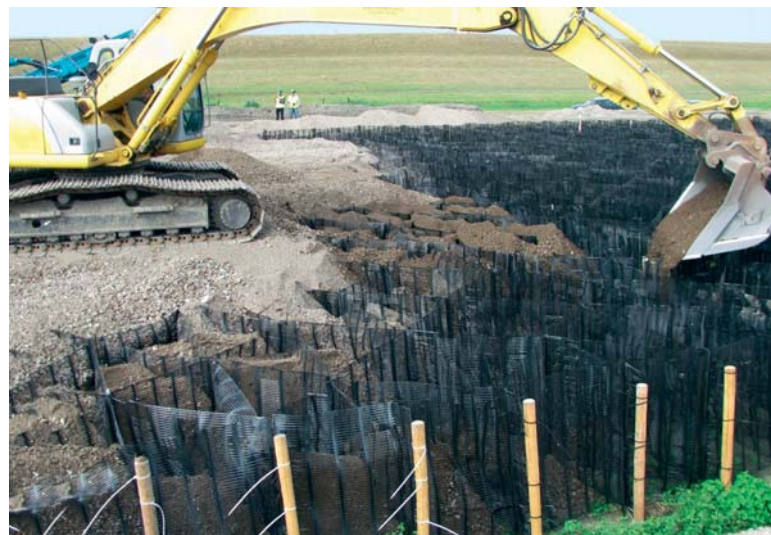
Foto 8 – Aanleg werkwegen met triaxiaal geogrid en non-woven.
