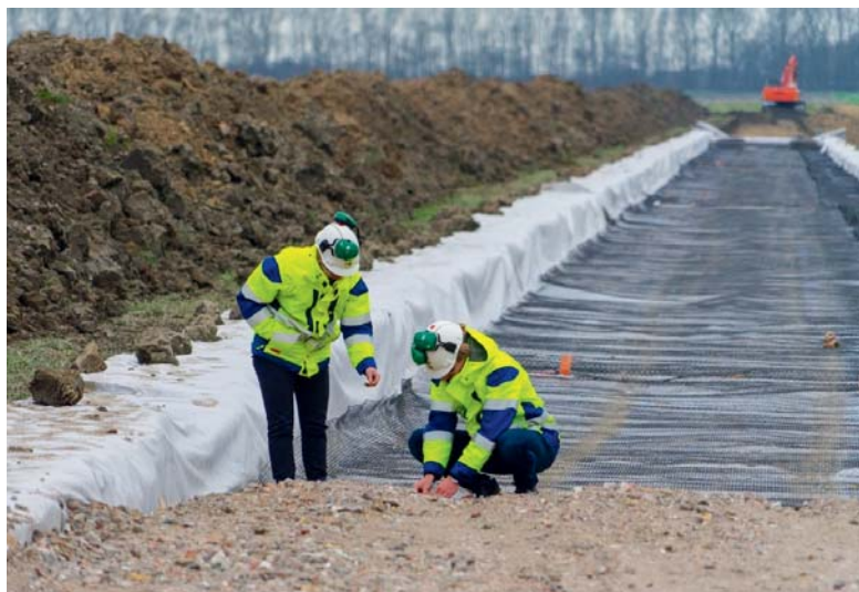
Foto 7 – Aanleg werkwegen met triaxiaal geogrid en non-woven.
