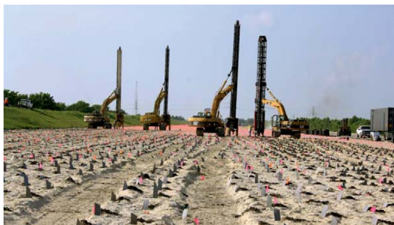
Figuur 10 – Aanbrengen verticale drains (ColbondDrain) ten behoeve van grootschalige dijkversterking rond New Orleans US. Referentie: Low & Bonar
