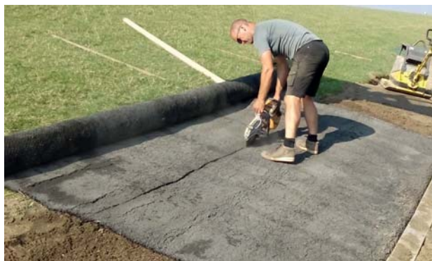
Figuur 4 – Aanleg erosiemat EnkaMat A20 proefveld overgangsconstructies binnentalud Waddenzeedijk augustus 2016.
