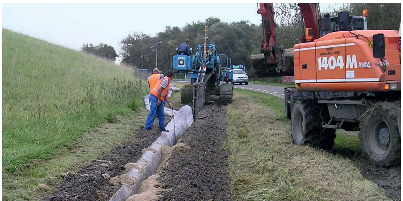
Figuur 12 – Aanbrengen teendrainage met geotextiel drainagemat (EnkaDrain Findrain) in teenconstructie waterkering Cadzand-Breskens.
