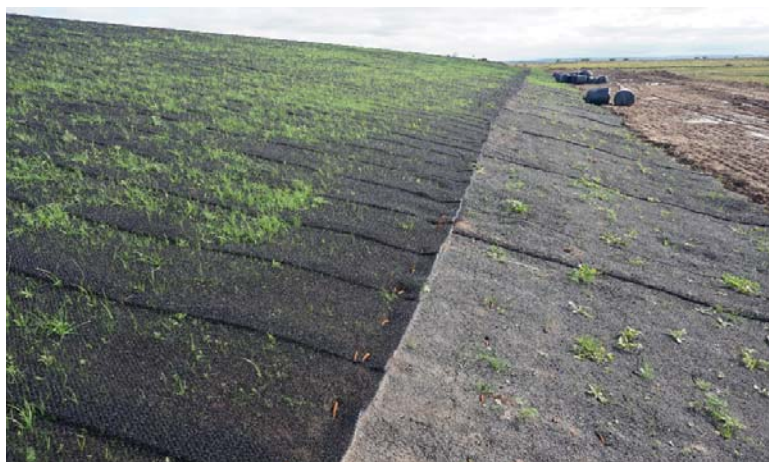
Figuur 2 – Erosiebescherming waterkering met beginnende vegetatie op een 3D-open of voorgevulde structuurmat met bitumen gebonden steenslag (EnkaMat A20). Referentie: Low & Bonar
