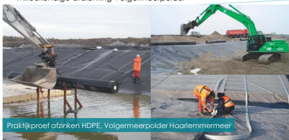
Introductie afdichting met geokunststoffen Milieukundige afdichting Volgermeerpolder Enka'solutions
