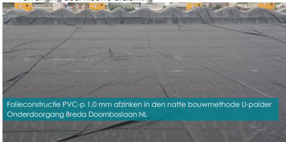
In den natte overtrekken hoofddeel folieconstructie naar kopscherm, Onderdoorgang Breda Doomboslaan NL
