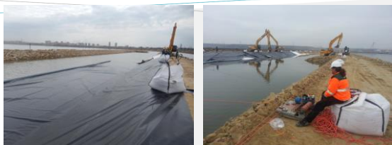
Aanbrengen van een hoog resistente folie (XR-5) op talud scheidingsdam door middel van afzinken met lierconstructie
