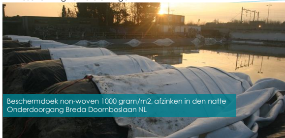
Beschermdoek non-woven 1000 gram/m 2 , afzinken in den natte Onderdoorgang Breda Doomboslaan NL
