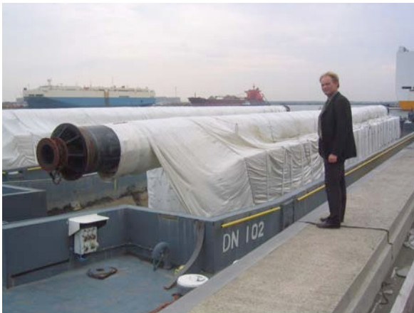
Foto 6: De balkvormige zand cement blok met daarop de stalen koker met opgerold geotextiel is klaar om te worden getransporteerd naar het legschip.
