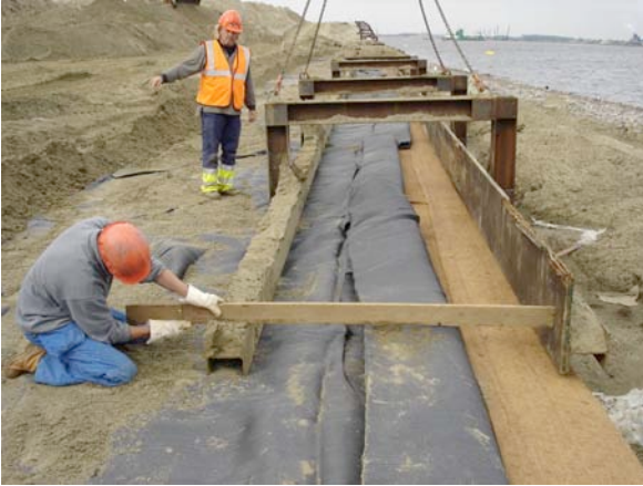
Foto 10: Het uitzetten van de frames wordt uitgevoerd met de grootste nauwkeurigheid.
