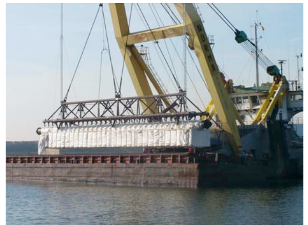
Foto 6 en 7: Uit de bekisting heffen van de balkvormige zand cement blok door een drijvende kraan. Daarna volgt plaatsen onder water door het legschip.
