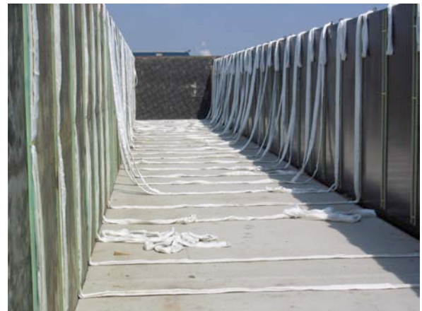
Foto 4: Bekisting met afmeting 30m (l) x 3m (b) x 2m (h) waarin het zand cementmengsel zal worden gepompt. De hijsbanden liggen klaar alvorens het PVC geomembraan en het voorgeconfectioneerde geotextiel wordt geplaatst.
