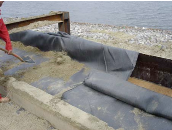
Foto 11: Aan de buitenkant van het frame wordt het geotextiel voorlopig over geplooid.
