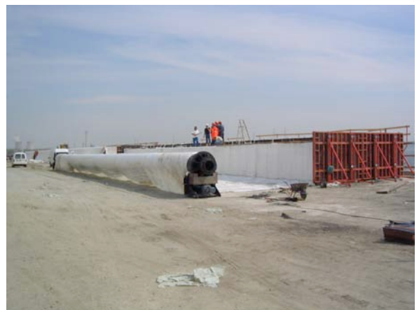
Foto 2: Oprollen geotextiel met lengte 100m en breedte 30m, plus 2,5m overlap, op stalen koker.
