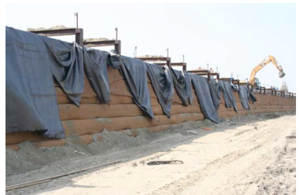
Foto 11: De overgevloide geotextielen zullen na aanvulling en verdichten van het zand achter het frame worden teruggeplooid.
