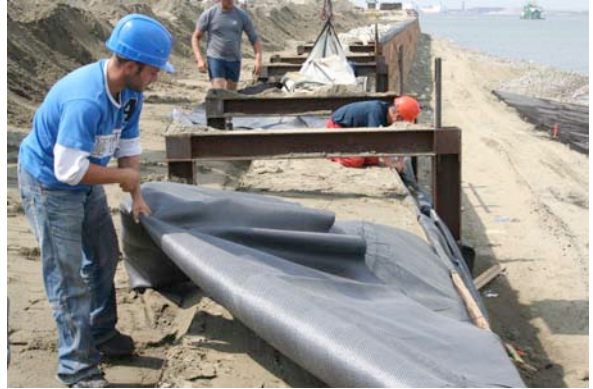
Foto 13: Het geotextiel wordt teruggeplooid, onder spanning gebracht en verankerd.
