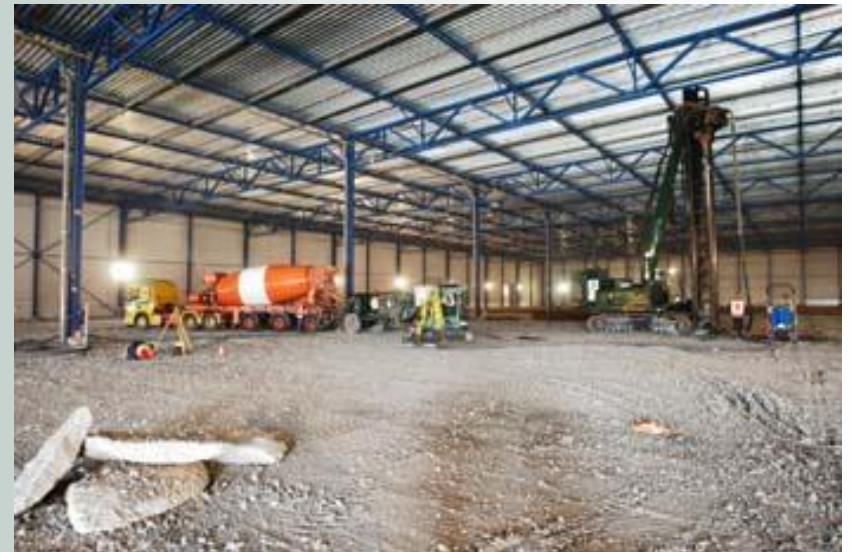
Renovatie bedrijfshal Moerdijk mrt – apr 2004
