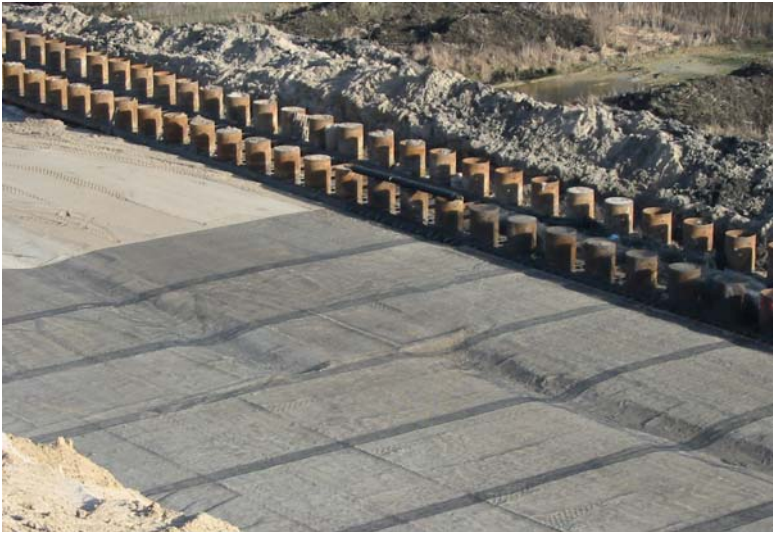
Foto 9 – Horizontale verankering van stalen buispalen.
