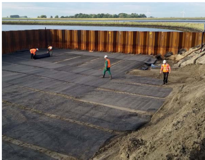
Figuur 13 – Bouwkuip kraanopstelplaats Krammer.
