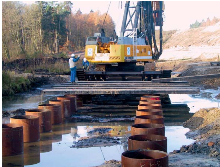
Figuur 10 – Werkplatform op stalen buispalen.
