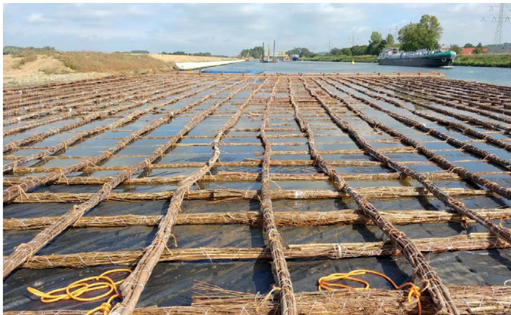
Figuur 7 – Zinkstuk met geotextiel onderlaag en rijshout vlechtwerk als filterconstructie onder stortsteen. Referentie: Kees Dorst
