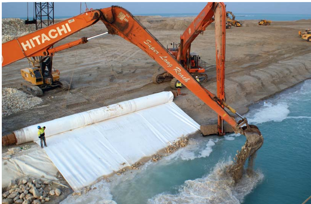
Figuur 6 – Kustverdediging met toepassing van een non-woven geotextiel als filterconstructie onder stortsteen. Referentie: Low & Bonar
