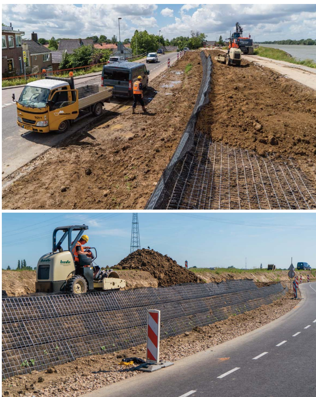
Figuur 8 – Uitvoering gewapende grondconstructie dijkversterking Kinderdijk-Schoonhovenseveer (KIS).
