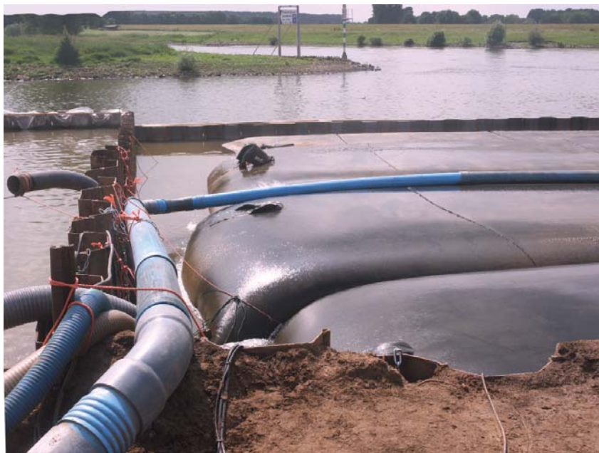
Figuur 10 – Vulling geotextiele tubes met baggerspecie met inbouw in vooroever De Mars Zutphen.
