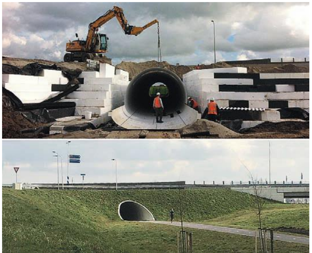
Figuur 5 – Lichtgewicht rotondeophoging met EPS met tunnelconstructie zonder paalfundering onder de N222.
