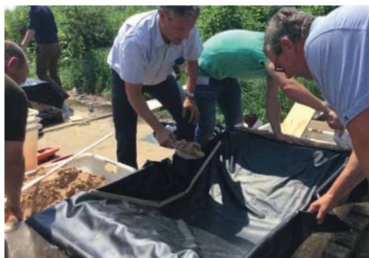
Figuur 4 – Proefopstelling bouwen: aanbrengen folieconstructie.
