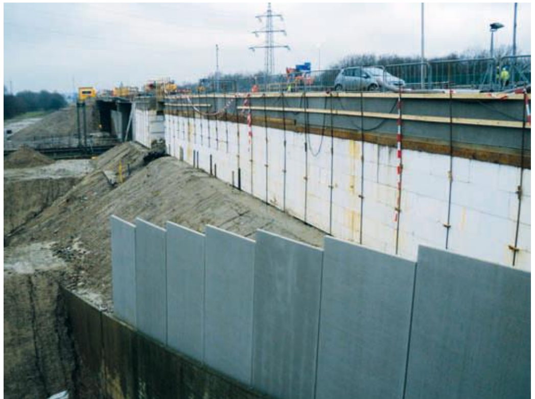
Figuur 4 – De snelwegverbreding van de A76 met tot 4 m hoog boven de taludlijn verticaal opgestapelde EPS-pakket.
