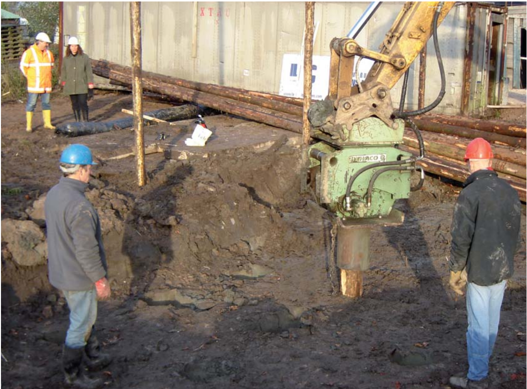
Foto 1 Aanbrengen houten palen voor de Kyotoweg.
