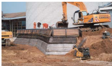
Steil talud, Noorder Dierenpark Emmen, gewapend met Enkagrid PRO
