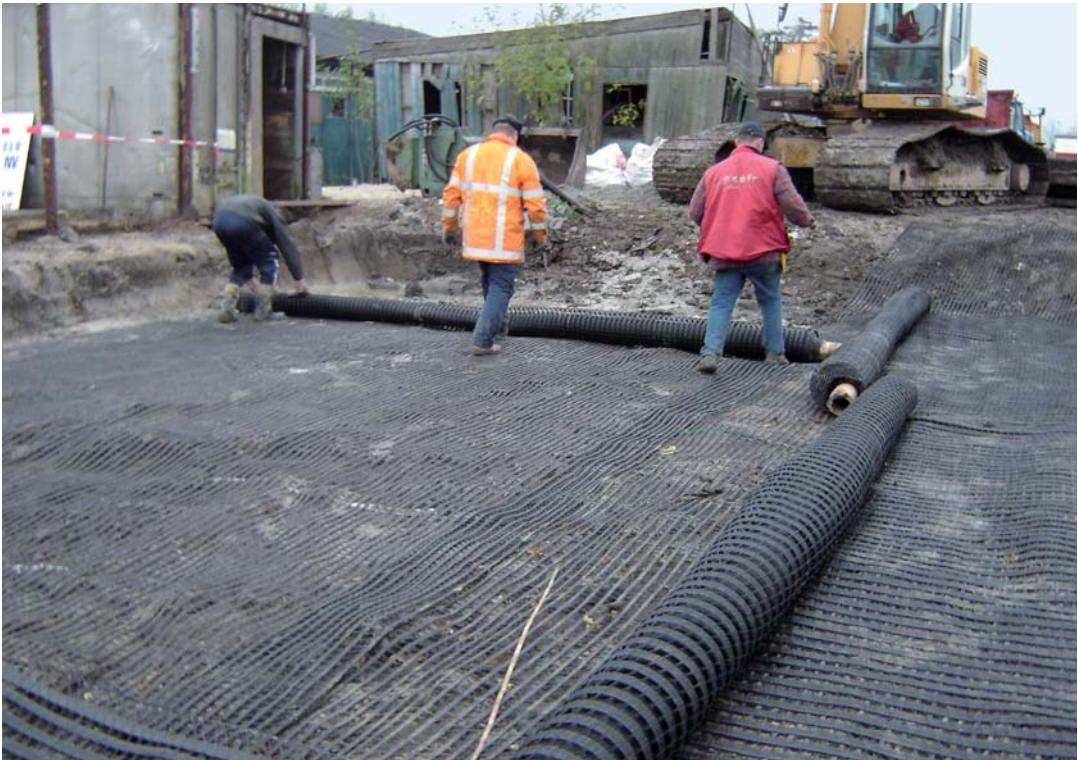
Foto 2 Aanbrengen geogrids voor de Kyotoweg.
