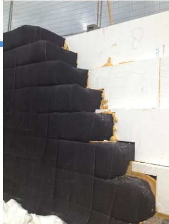
Uitvoering Paalmatras-EPS
